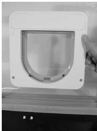
Når du er fornøyd, setter du på den store dekkplaten og fester den godt med de fire selvgjengende festeskrueene. Klikk den lille dekkplaten på plass. Sett alle dekkpluggene – fire små for de selvgjengende festeskrueene og to store for M6-skrueene – på plass. Til slutt kan du slå på strømmen til Petporte smart flap®.
