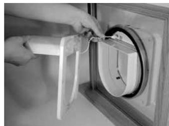
Når du tilpasser Petporte smart flap® i en åpning, holder du om nødvendig den innvendige delen med forlengelsestunnelen opp til åpningen. Deretter fører du utspringkabelen fra utspringet og den utvendige delen gjennom den rektangulære åpningen i den innvendige delen.
