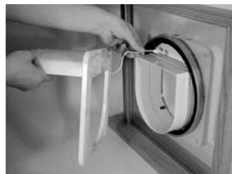
Når Petporte smart flap® skal monteres i en åbning, holdes den indvendige sektion med forlængertunnellen, hvis sidstnævnte skal bruges, hen til åbningen. Dernæst føres ledningen fra vindfanget og den udvendige sektion gennem den rektangulære åbning i den indvendige sektion.
