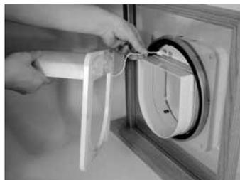
Kun asennat Petporte smart flap® -luukun aukkoon, asenna tarvittaessa sisäosan lisäkätävä. Vie portaan johto sen jälkeen portaan ja ulko-osan läpi sisäosan suorakulmaisen aukon läpi.
