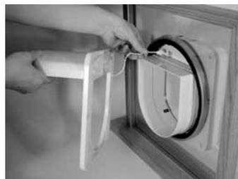
Vid montering av Petporte smart flap® i en öppning, för den invändiga delen med förlängningstunneln vid behov upp till öppningen. Mata sedan portalkabeln från portalen och den utvändiga delen genom den lilla rektangulära öppningen i den invändiga delen.
