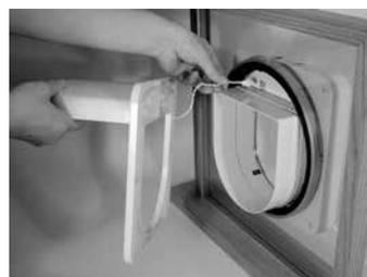
Устанавливая дверцу Petporte smart flap® в отверстие, приложите к отверстию внутреннюю часть с удлинителем туннеля, если он требуется. Затем проведите кабель козырька от козырька и внешней части дверцы сквозь прямоугольное отверстие на внутренней части.
